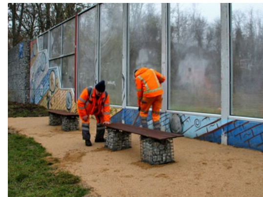
Mitarbeiter des Bauhofs setzen die neuen Bänke
