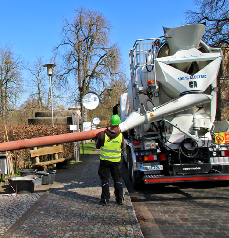
Betonanlieferung im Museumspark mit elektrischem Fahrmischer
