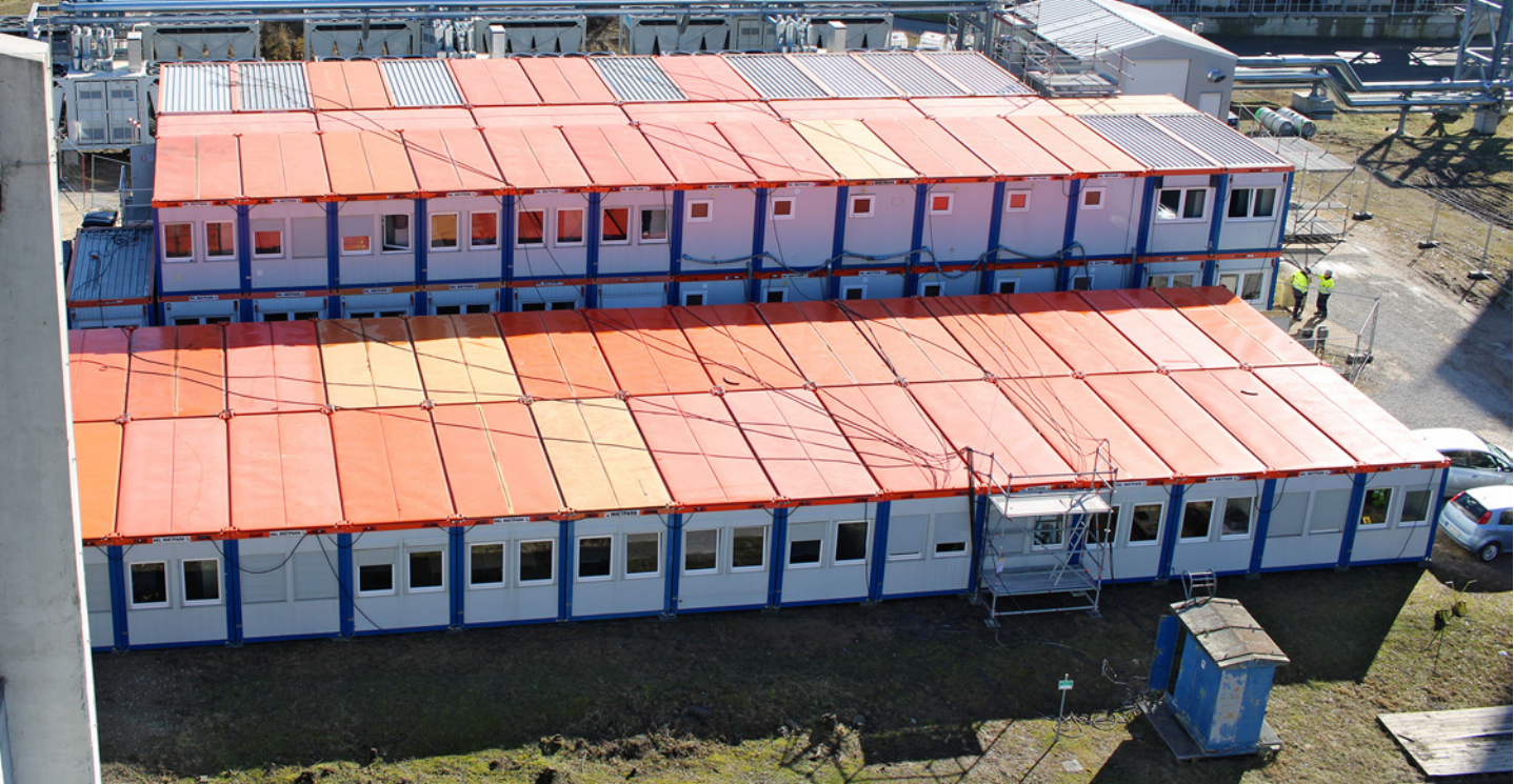
Containerburg auf dem Werksgelände während der Winterreparatur
