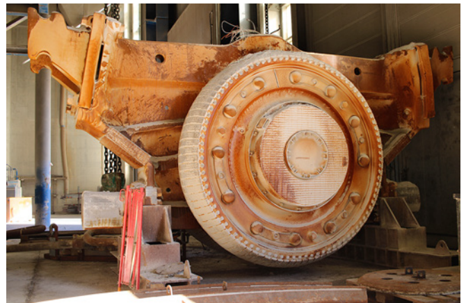
Rohmühle: Wartung/Instandsetzung der Mahlrollen zur Kalksteinzerkleinerung
