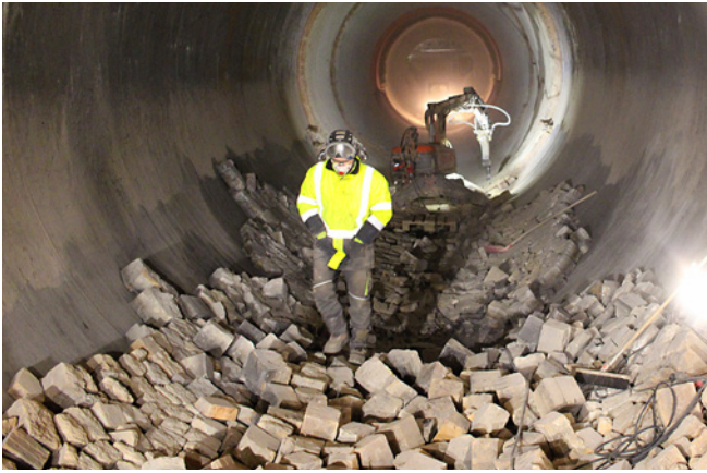
Ofenanlage: Ausbau/Erneuerung verschlissener Feuerfeststeine
